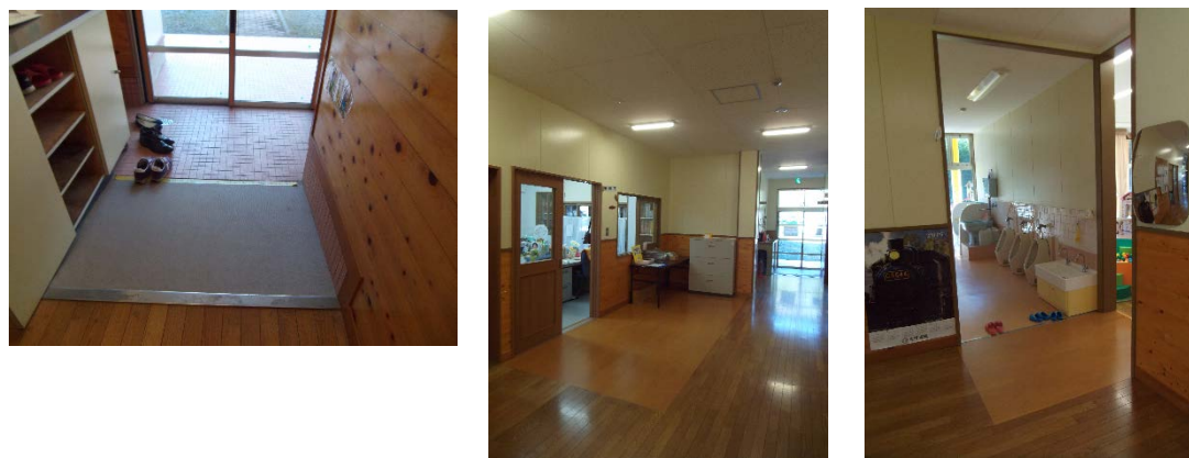
(左端) 玄関は、既存床タイルを高圧洗浄 (中央) 天井は全面的に張替え (右端) 来場する親子の姿が事務室から見えるように壁にミラーを設置
