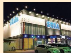
施工事例 セガ旭店
