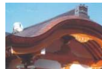
専念寺唐破風銅板工事
