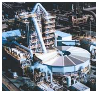
◆リサイクルプロセス全体像 (※右下のドーナツ形が「回転炉床還元炉」)
