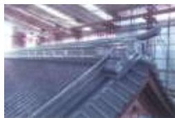
金沢城復元工事(河北門屋根工事)
