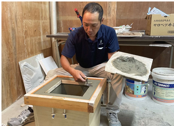
こて [茶室用の本炉の炉縁を鏝にて整えている作業]
