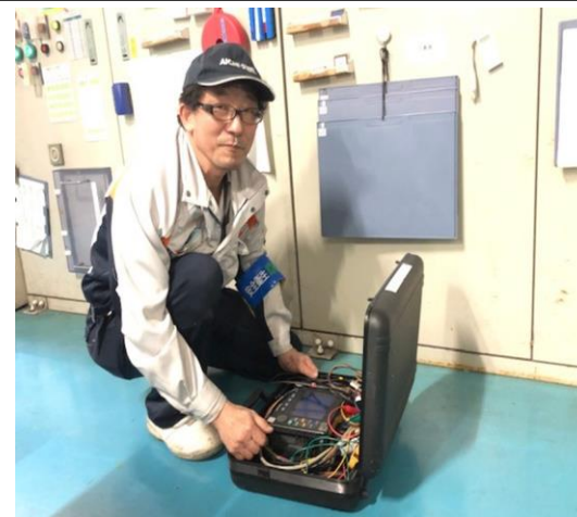
〔負荷診断器（電力診断器）の手作り〕
