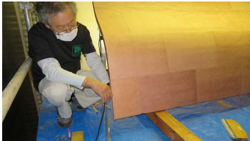
〔長野市指定文化財鬼無里神社祭屋台の屋根和紙葺き工事〕
