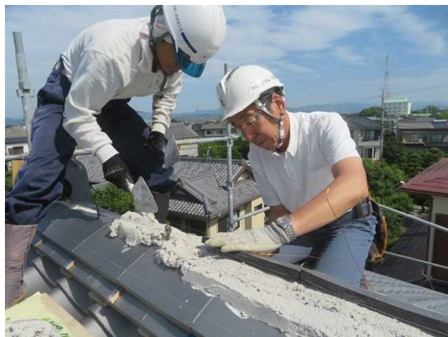
〔築地葺きによる棟積み施工〕
