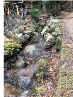
[流れ石積み技法を用いた、小河川の改修事業]
