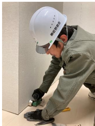
[長尺シート貼り 圧着作業]
