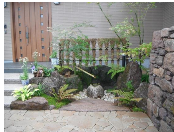
【玄関前の自然石蹲・竹穂垣・砂岩鉄平乱張り・彼杵石の石積】
