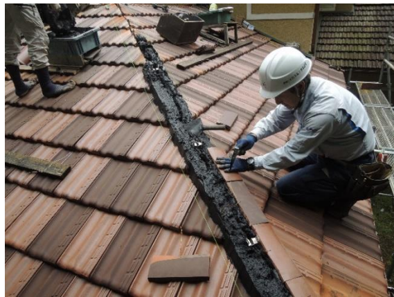
[昭和初期のフランス瓦復原施工現場の状況]
