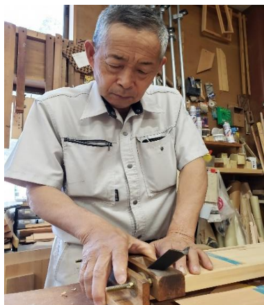
〔組子用鉋で部材加工の作業中〕
