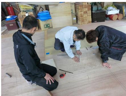
[曲尺を用いて原寸図を作成]
