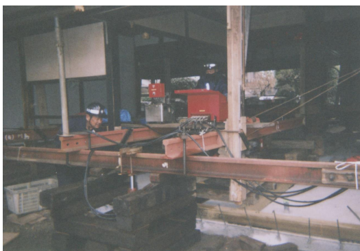
【 揚げ家工事 （家を持ち上げる段取り作業）】
