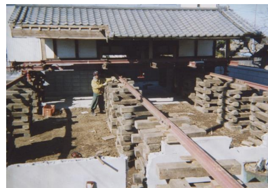
【 曳家工事 （家を移動させる為のレールを敷設）】
