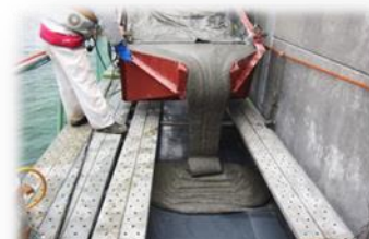
施工：生産性向上
