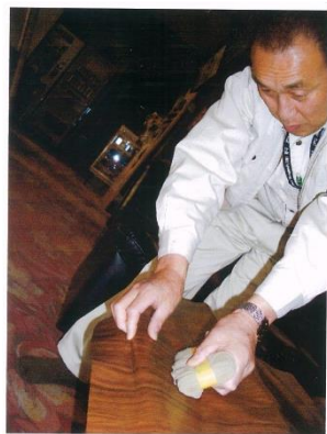
タックシートの乾式工法作業風景
