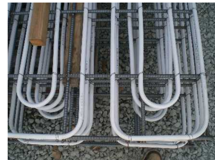
無散水融雪装置(曲げ加工部)
