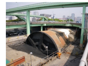
到達状況(高速道路工事)
