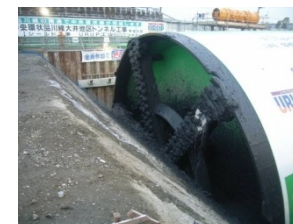
発進状況(高速道路工事)
