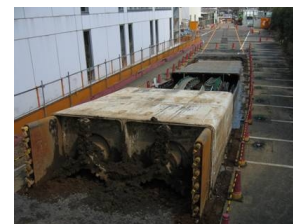
到達状況(実証実験工事)
