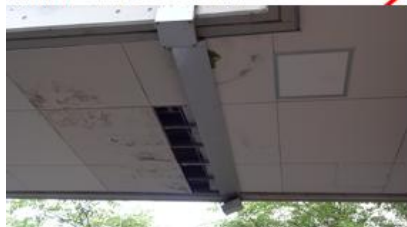
天井落下 (2階渡り廊下の床裏)
