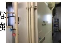
空調機更新（放送研究棟）
