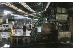
④ プラントの保守・診断技術
