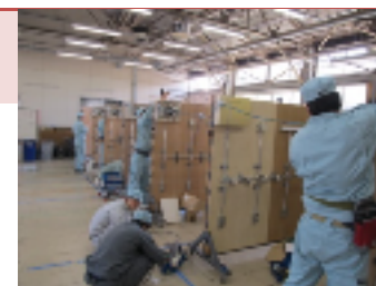
屋内配線工事实習
