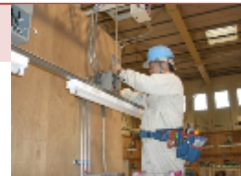
屋内配線工事実習
