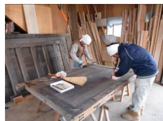
修復作業の様子
