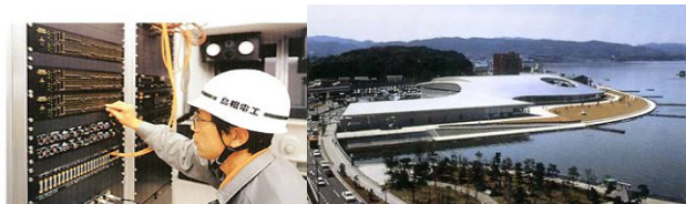
県下有数の工事を手がける島根電工
