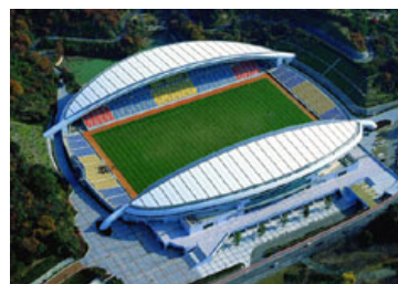
東平尾公園球戯場(屋根工事)
