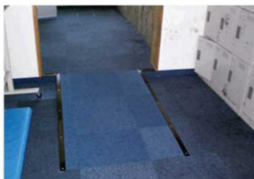
事例1：スロープの設置
