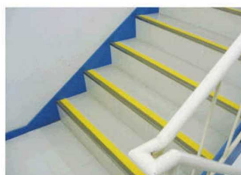
事例4：視覚障害者が認識しやすいように階段にテープを貼る
