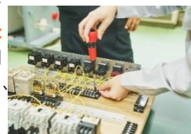
▲シーケンス制御回路の配線作業
