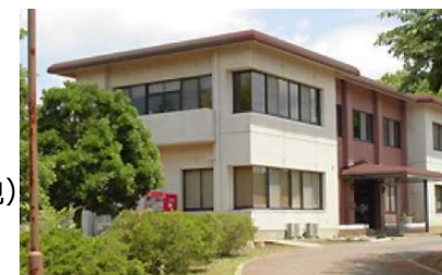
建物外観 （社会福祉法人ワナーホームHPより）
