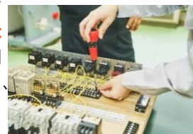
▲シーケンス制御回路の配線作業
