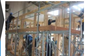
住宅リフォーム技術科 (模擬家屋施工実習の様子)
