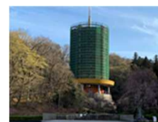
納骨堂改修工事のため休館中
