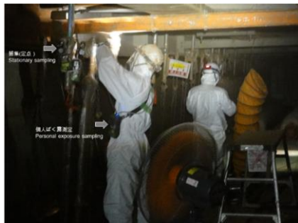
化学物質ばく露による労働災害の原因調査現場
