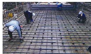
現場施工の現状（イメージ）
