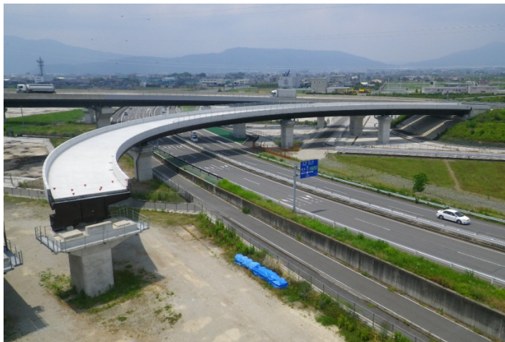
国土交通省中部地方整備局 東海環状大垣西1Cランプ橋床版工事
