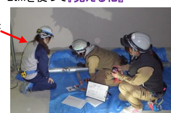
①-2 施工管理の状況
