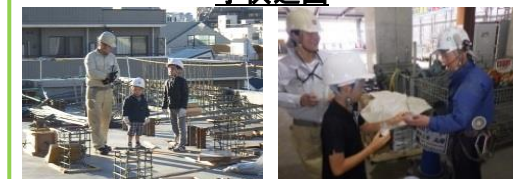
躯体工事見学
