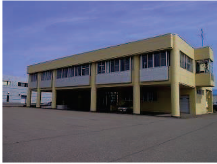
新潟県工業技術総合研究所 中越技術支援センター
