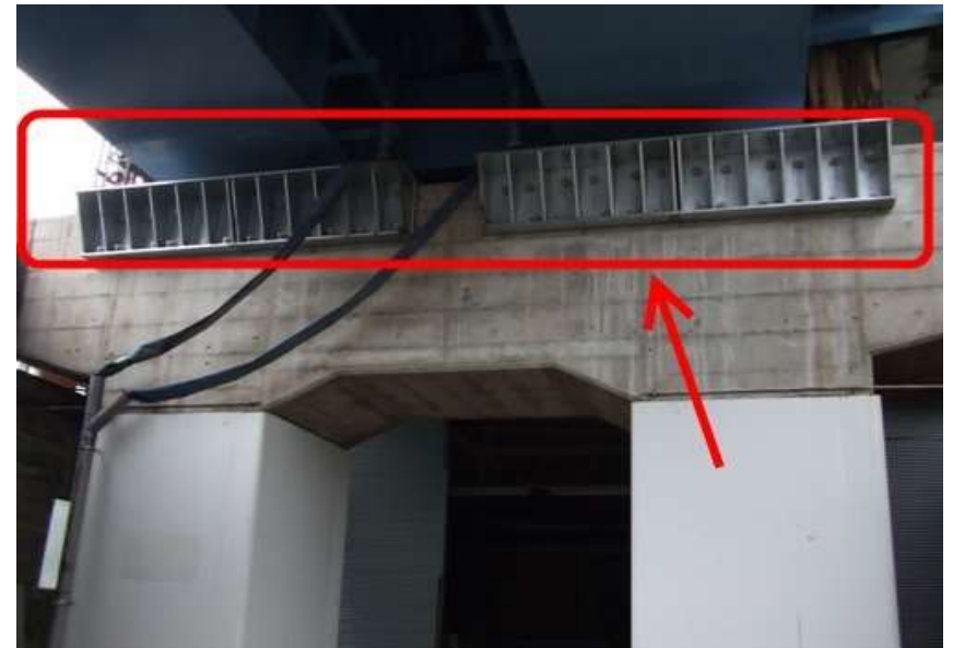
鋼製ブラケットによる縁端拡幅
