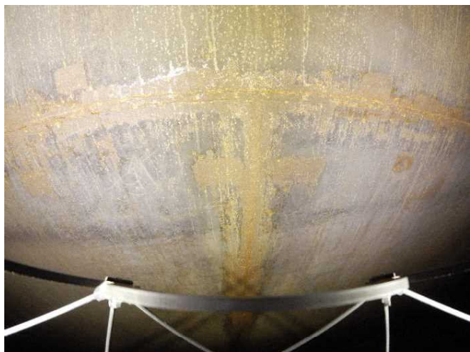
壁面の溶接線
