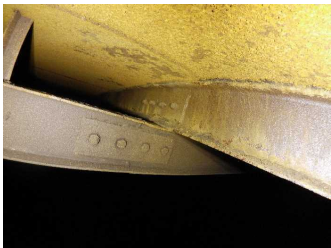
天井のボルト
