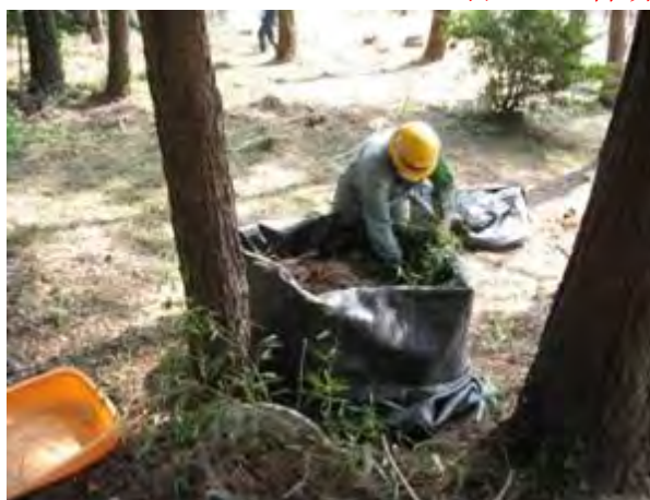
フレキシブルコンテナに詰める作業
