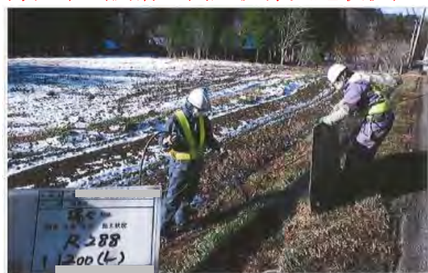
汚泥系（側溝の高圧洗浄実施状況）
