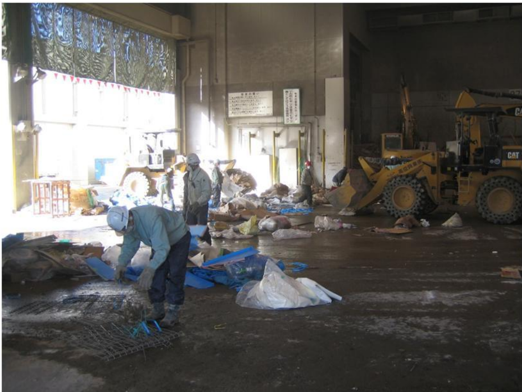
ダンピングヤード 作業員による廃棄物の選別（使い捨て防じんマスク着用）
