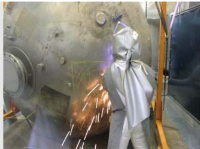
プラズマ切断機を用いた切断
