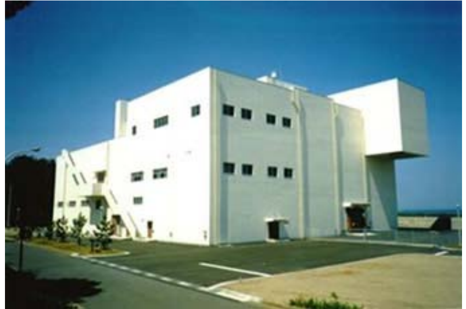
【解体分別保管棟】
