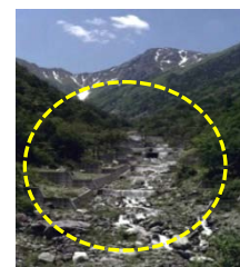
昭和62年（施工直後）
