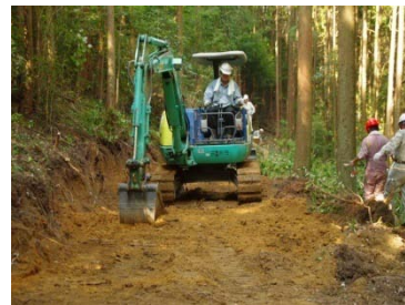
作業道作設作業
