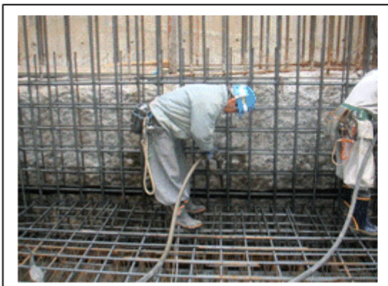
コンクリートバイブレーター
