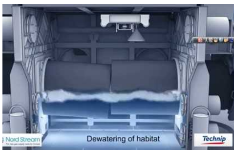
ドライチャンバー内排水状況(Technip)
