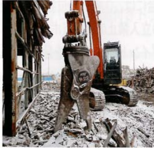
コンクリート圧碎機 (コンクリート構造物 を砕く)
