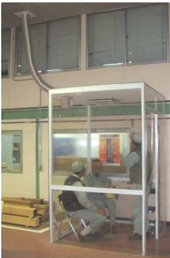
建築で使用する安価な部材を利用して箱を作成
