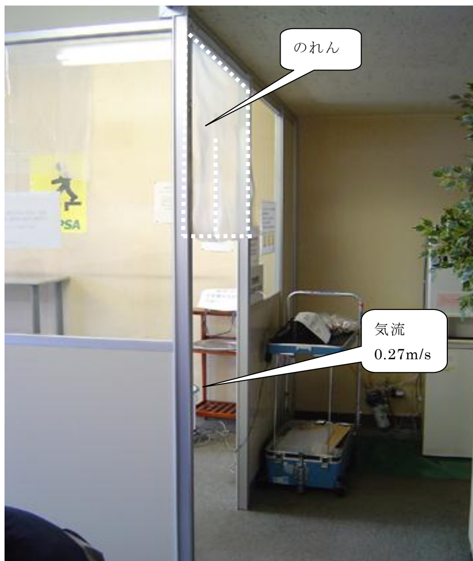
出入口にのれんを設置して、開口部分の気流を 0.20\text{m/s} から 0.27\text{m/s} に強化した事例（排気風量 1,160\text{m}^3/\text{h} ）
