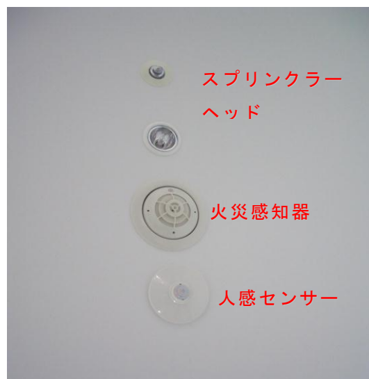
喫煙室にスプリンクラーヘッド及び感知器を増設した事例
