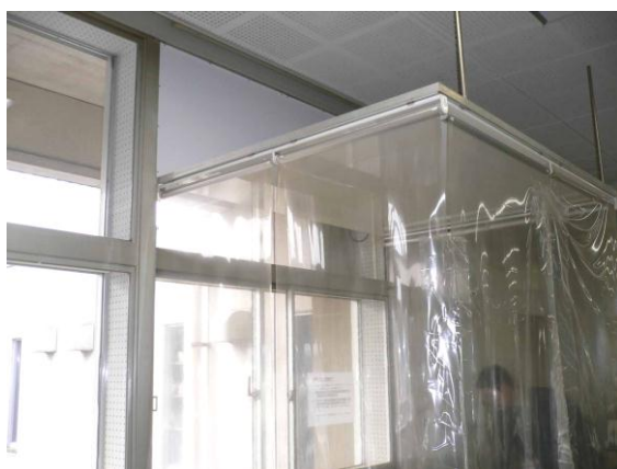
排気口：屋内側の窓を外し下3分の1を排気口とし、さらに、屋内下側の窓を開けることで二重窓の間の空間を通して排気が行われる
