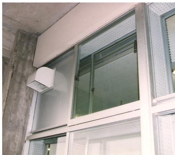
換気扇：屋外側の窓を外して窓枠に換気扇を固定
