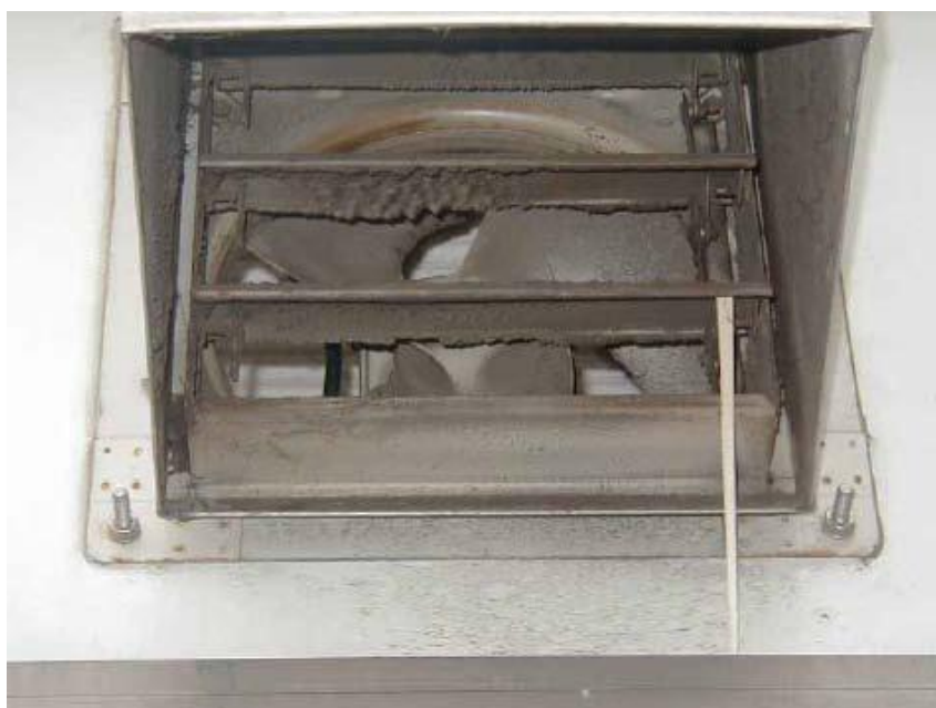
換気扇メンテナンス後 シャッターが完全にあがるように支え棒を設置
