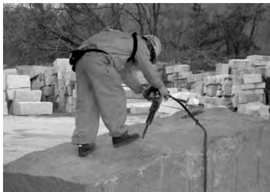
作業者 D-3, 6, 8, 9 (削孔：小割)
