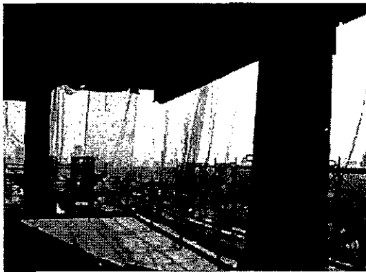
4 側面の換気状況
