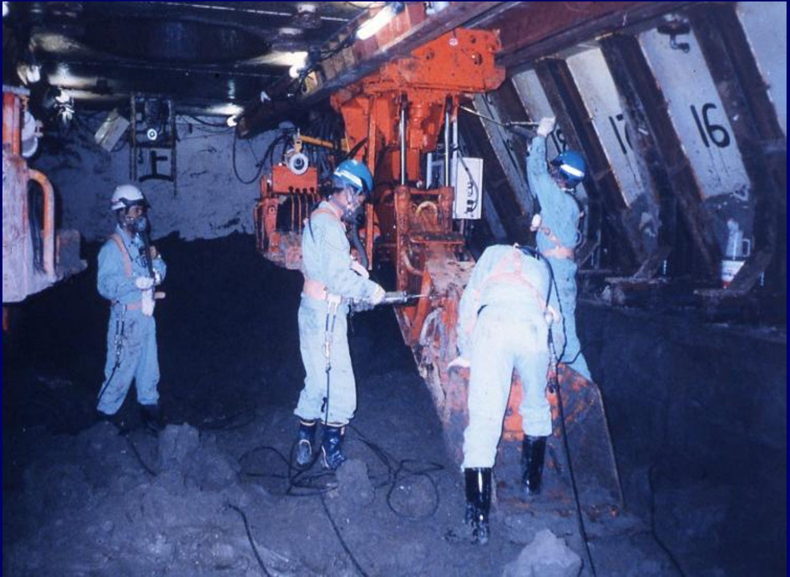
Trimix gas を用いた函内作業風景
