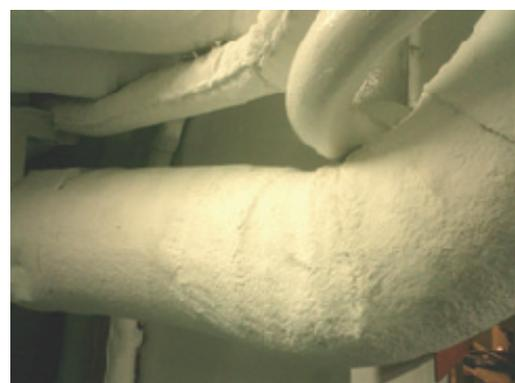
図2-5 アスベスト系を布状にしたクロス（左）及び アスベストクロスを巻き付けた蒸気配管（右）
