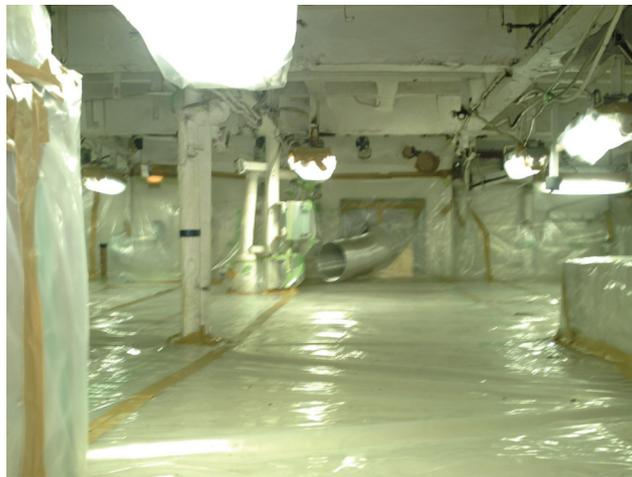
図 5-1-2 工事区画をプラスチックシート等で密閉隔離（床面は 2 枚重ね）。
