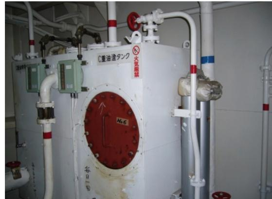
図2-4 タンクの保温板。保温板の表面にアスベストクロスを貼り付けて金網で補強（左）
