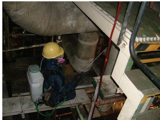
図5-1-12 噴霧器を使用してのアスベストの湿潤作業中
