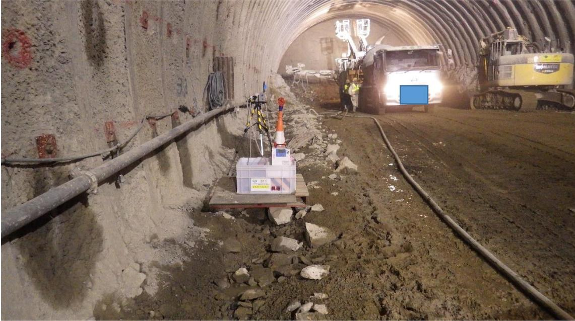
写真3 現場 F における定点測定機器設置の様子
