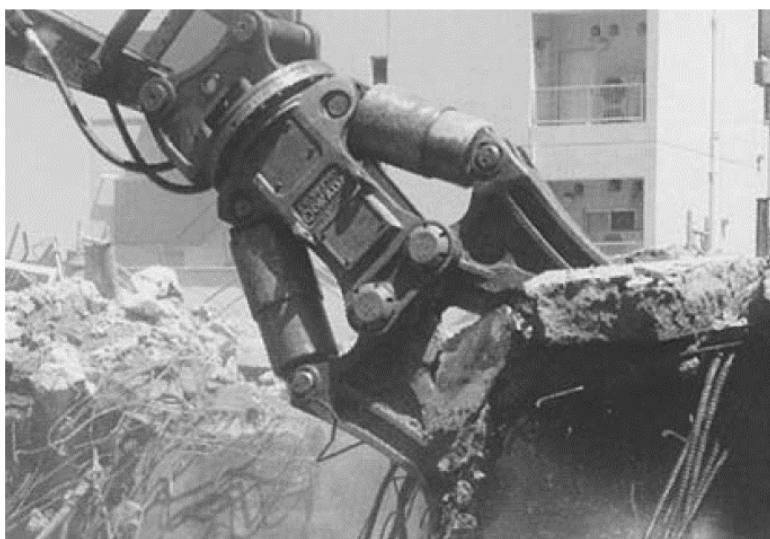
ภาพถ่ายที่ 4-3 สภาพการรื้อถอนงานโครงสร้างและสิ่งก่อสร้างคอนกรีตแบบบดหยาบ
