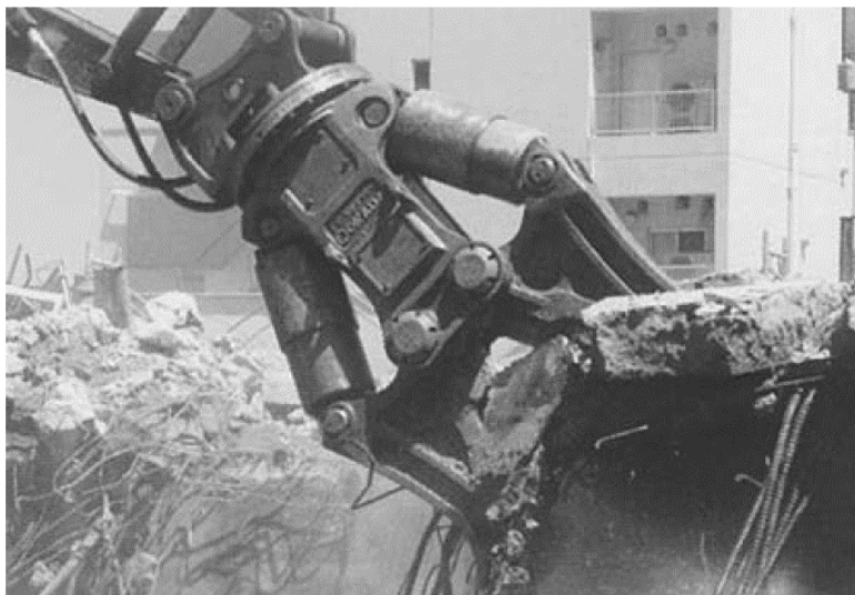
तस्बिर 4-3 कङ्क्रीटको निर्माण संरचना तथा भवनको टूलो कटिंगको विघटन स्थिति
