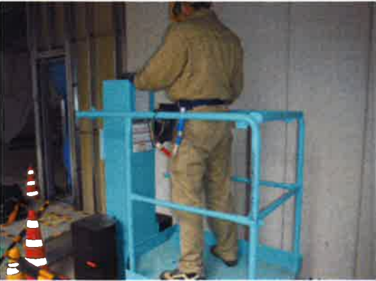
(手すりにフックを掛ける: 斜め側面)
