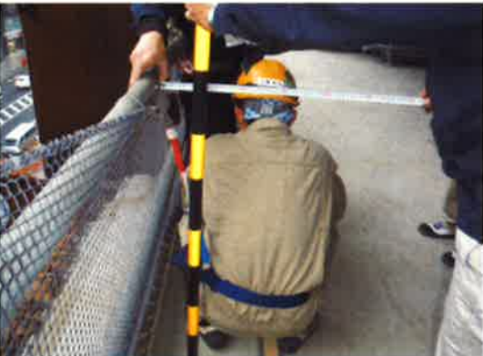
(ランヤード0.6mでの実証: 床面作業)
