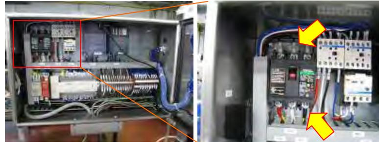
図 13. 操作盤内の電氣的危険源
