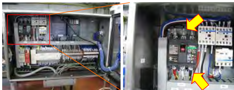
図 13. 操作盤内の電氣的危険源
