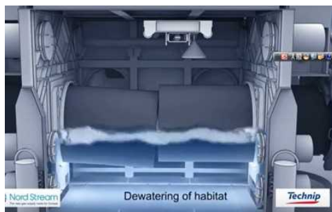
ドライチャンバー内排水状況(Technip)
